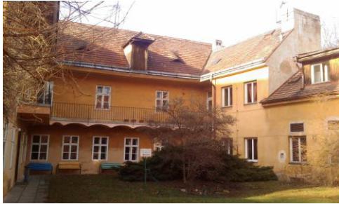
Vnitřní pohled na budovu Denního sanatoria Horní Palata
